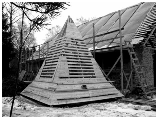
Kapellet med takkonstruktionen för tornet.
