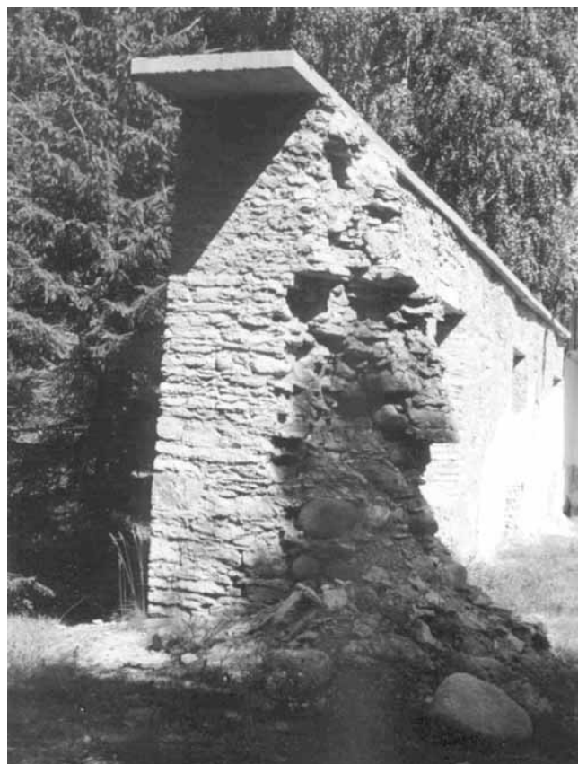
Norra långväggens hörn mot den nästan helt raserade tornväggen. Foto: Sture Koinberg
